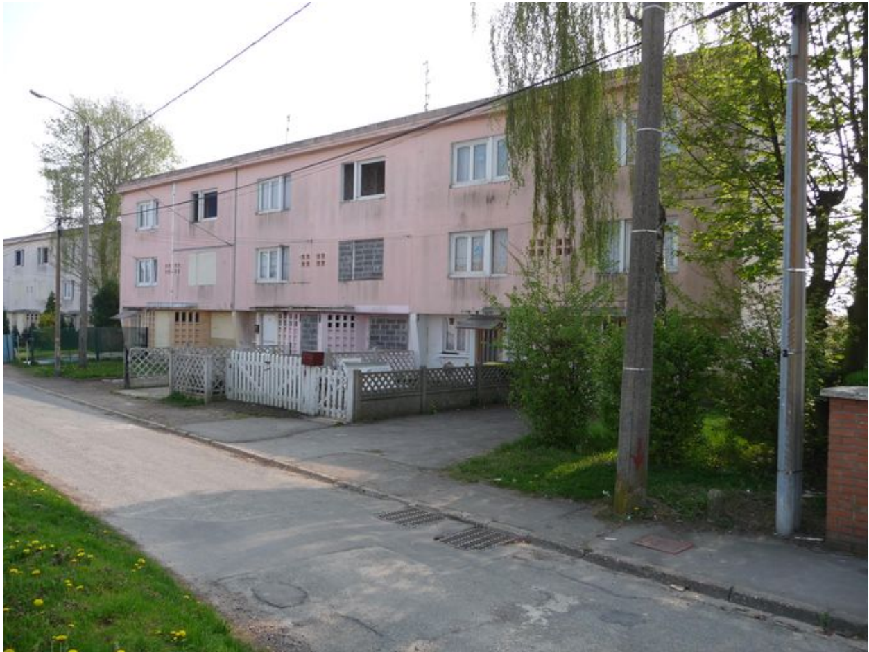
Vue générale d'un groupe de six logements.
