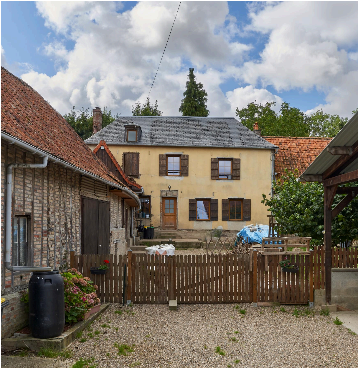
Exemple de maison en pans de bois à deux étages, 17 rue de Haut.
