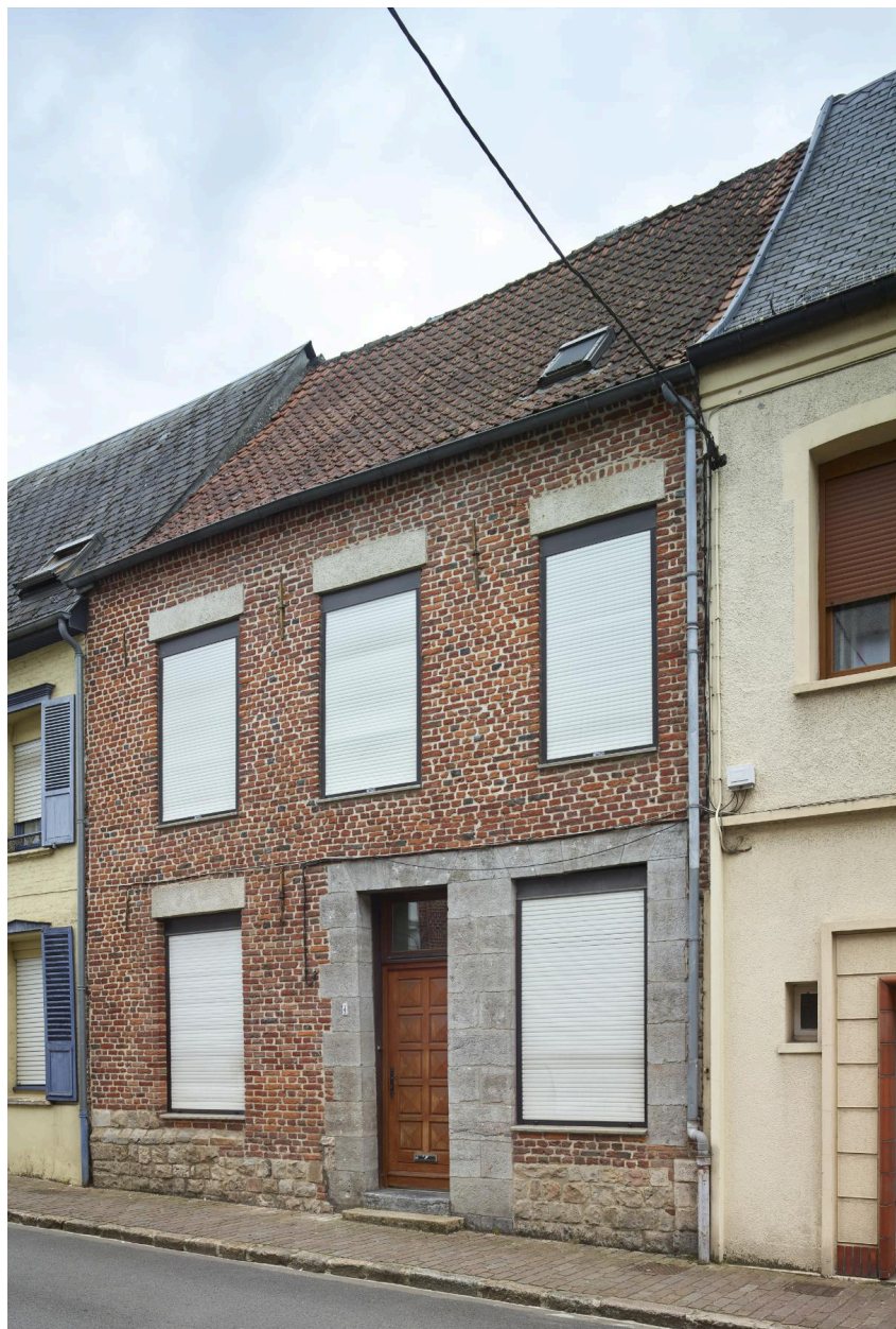
Maison, XVIIe siècle : soubassement en grès et rare entourage de la totalité des baies en pierre bleue, trois travées avec la porte au centre - 4, rue Jean-Jaurès.
