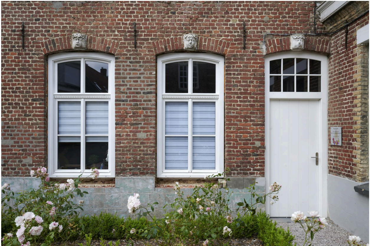
Détail des baies en rez-de-chaussée. Pavillon ouest. Façade sur cour.
