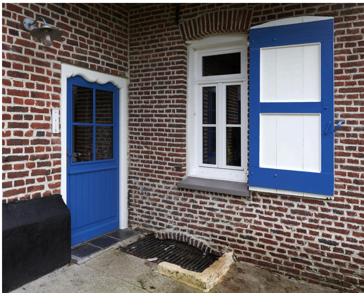
Porte secondaire et baie.
