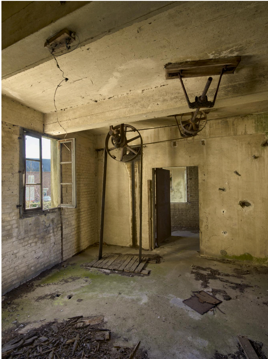
Arbre de transmission, poulies et courroies.
