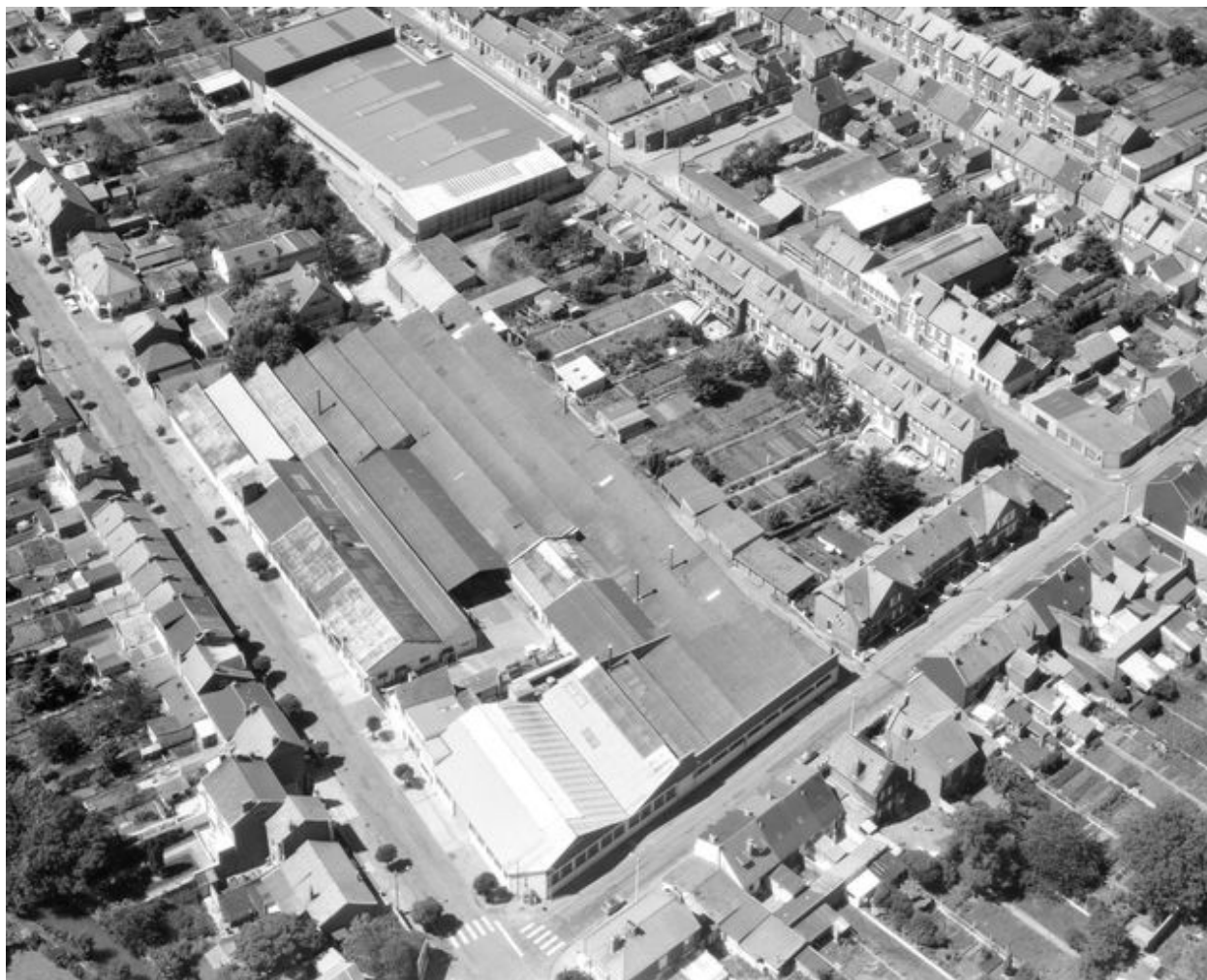
Vue aérienne, flanc nord-est.
