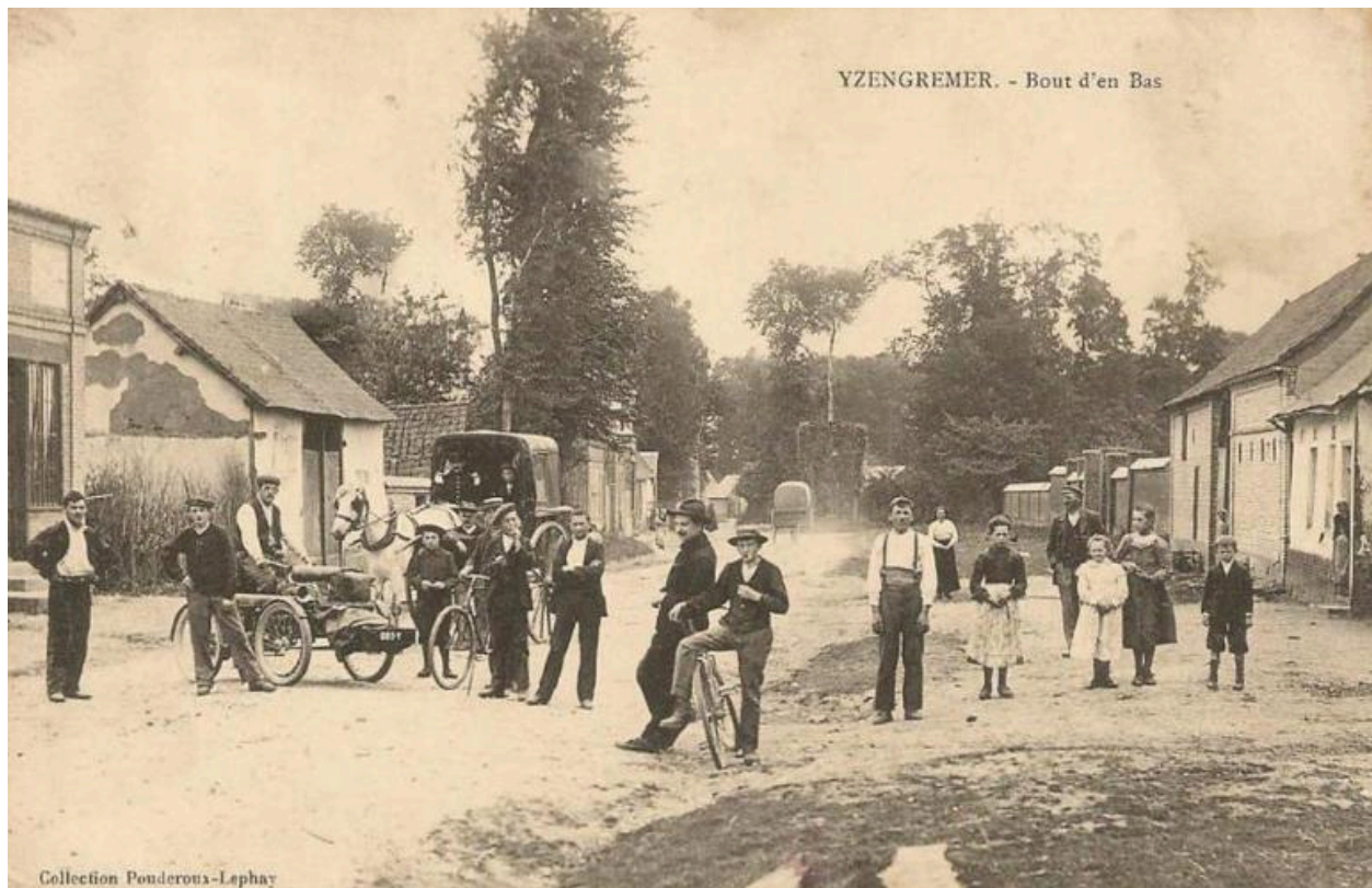
La rue Saint-Médard (ancienne rue d'en Bas) depuis l'est, début du 20e siècle (coll. part.).
