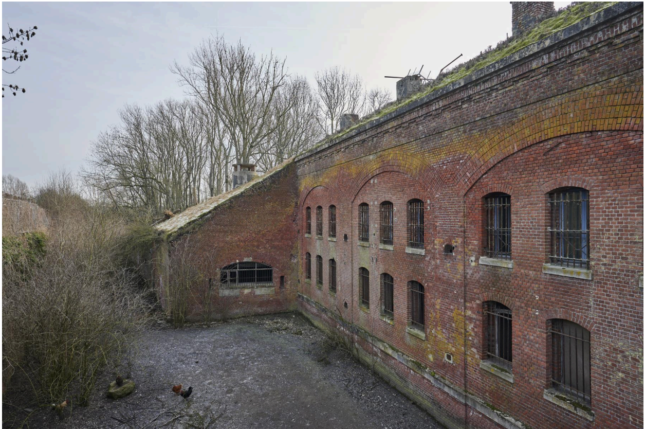
Élévation nord, caserne de gorge et batterie de flanquement ouest.
