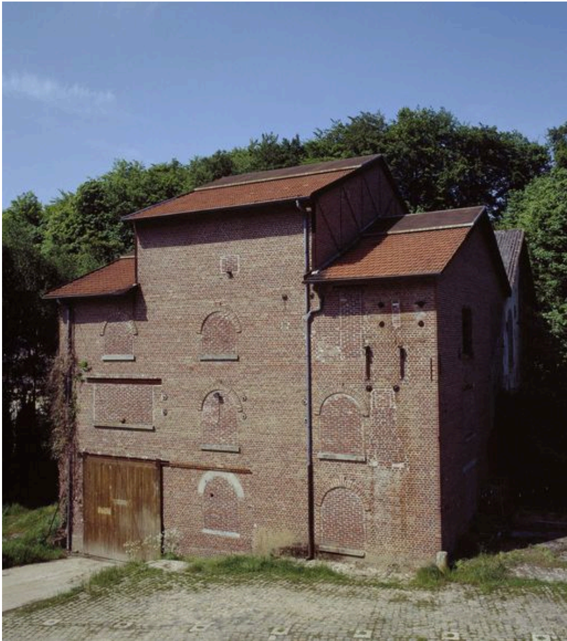
L'ancienne distillerie, façade sud.
