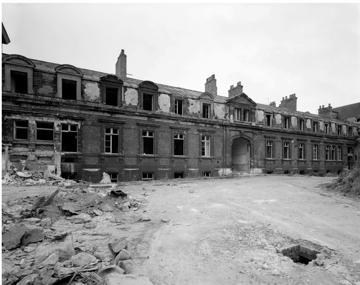
Bâtiment A, façade sur cour.
