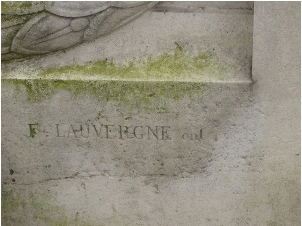
Vue de détail sur la signature de l'entrepreneur : F. Lauvergne.
