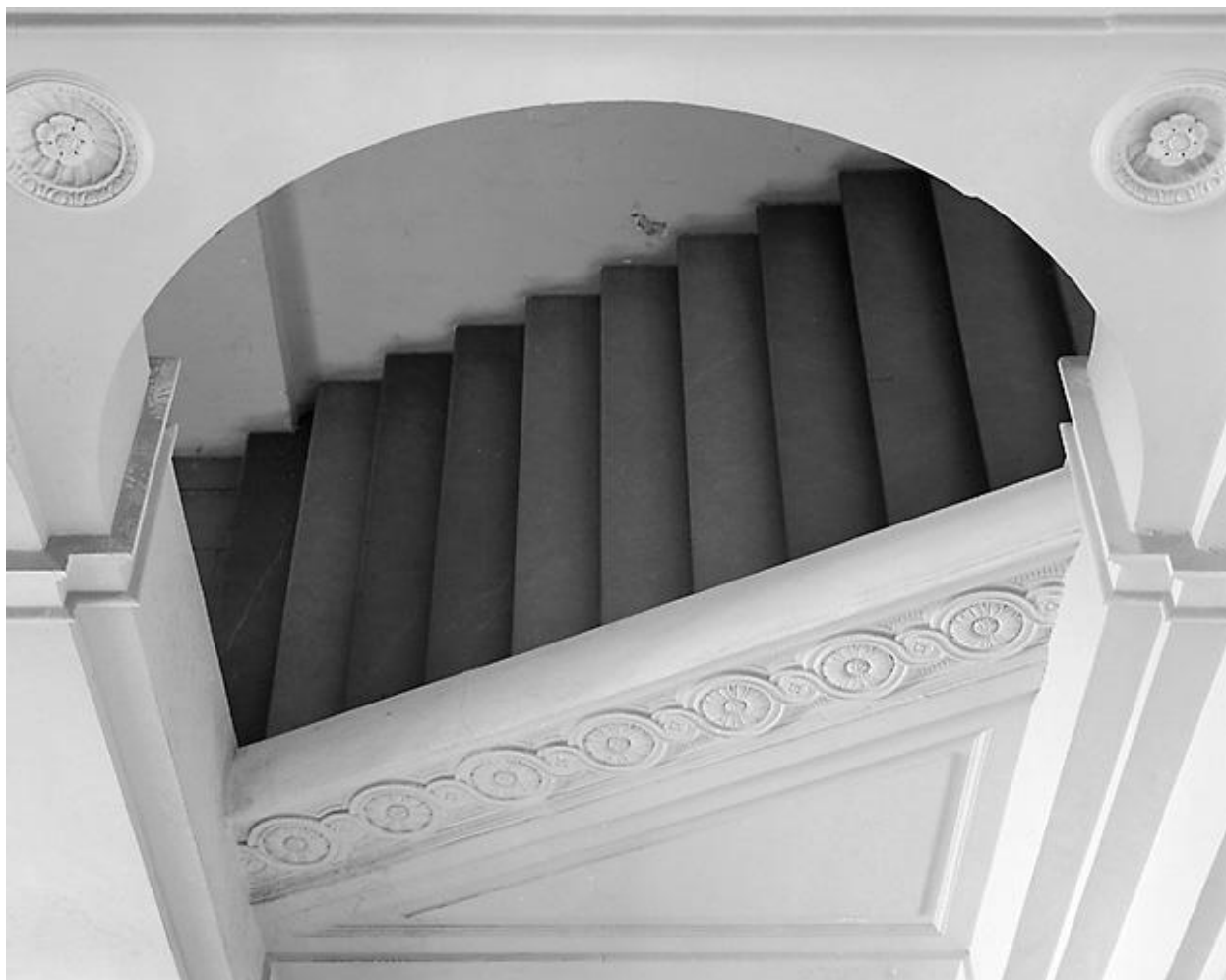
Palais de justice, escalier d'honneur : vue plongeante.
