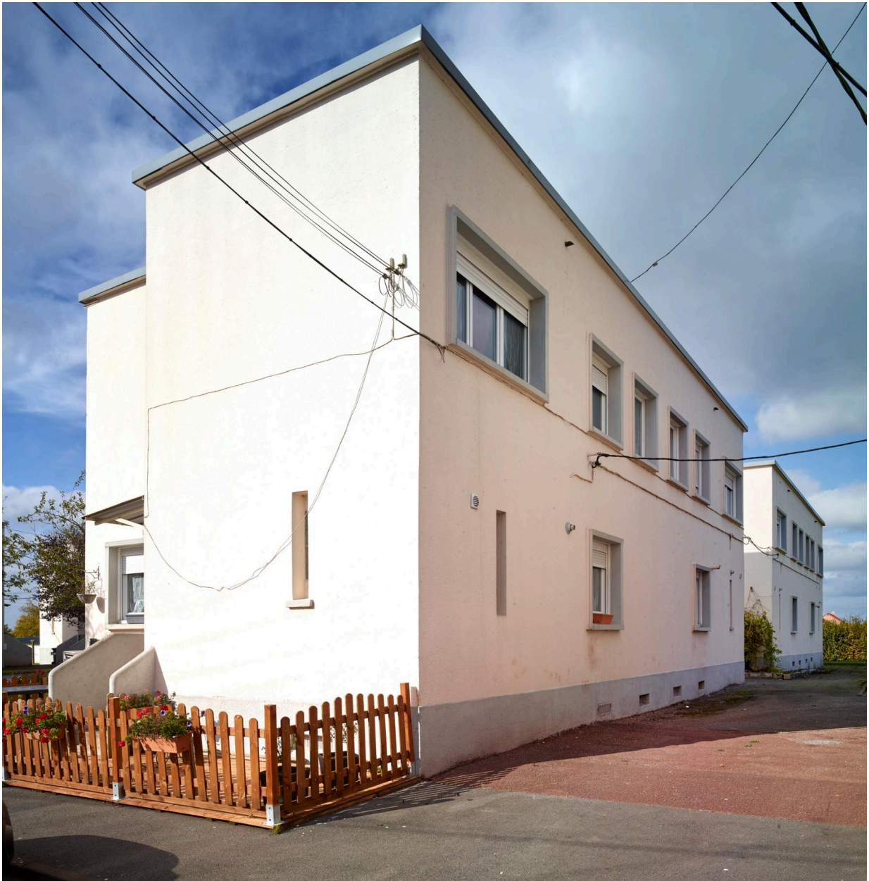
Vue arrière des pavillons, prise depuis la rue.
