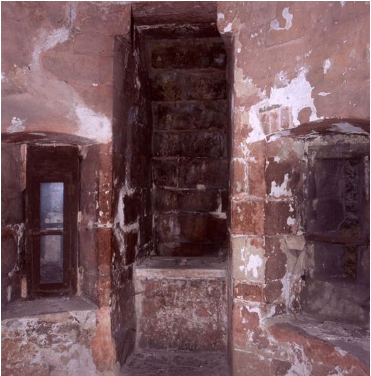
Corps de logis médiéval, intérieur, 2e étage, tourelle nord, vue partielle : latrines.
