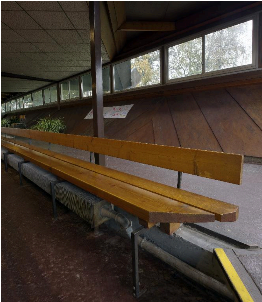
Vue de détail du système de chauffage.
