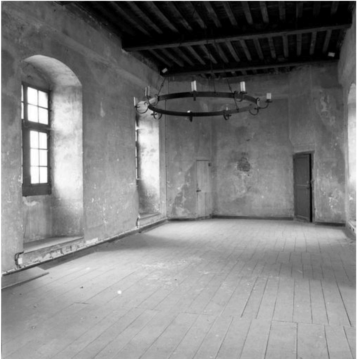
Corps de logis médiéval, intérieur, 2e étage, grande salle : vue générale vers le sud-ouest. Au fond à droite, la porte donnant accès à la tourelle d'escalier ouest.
