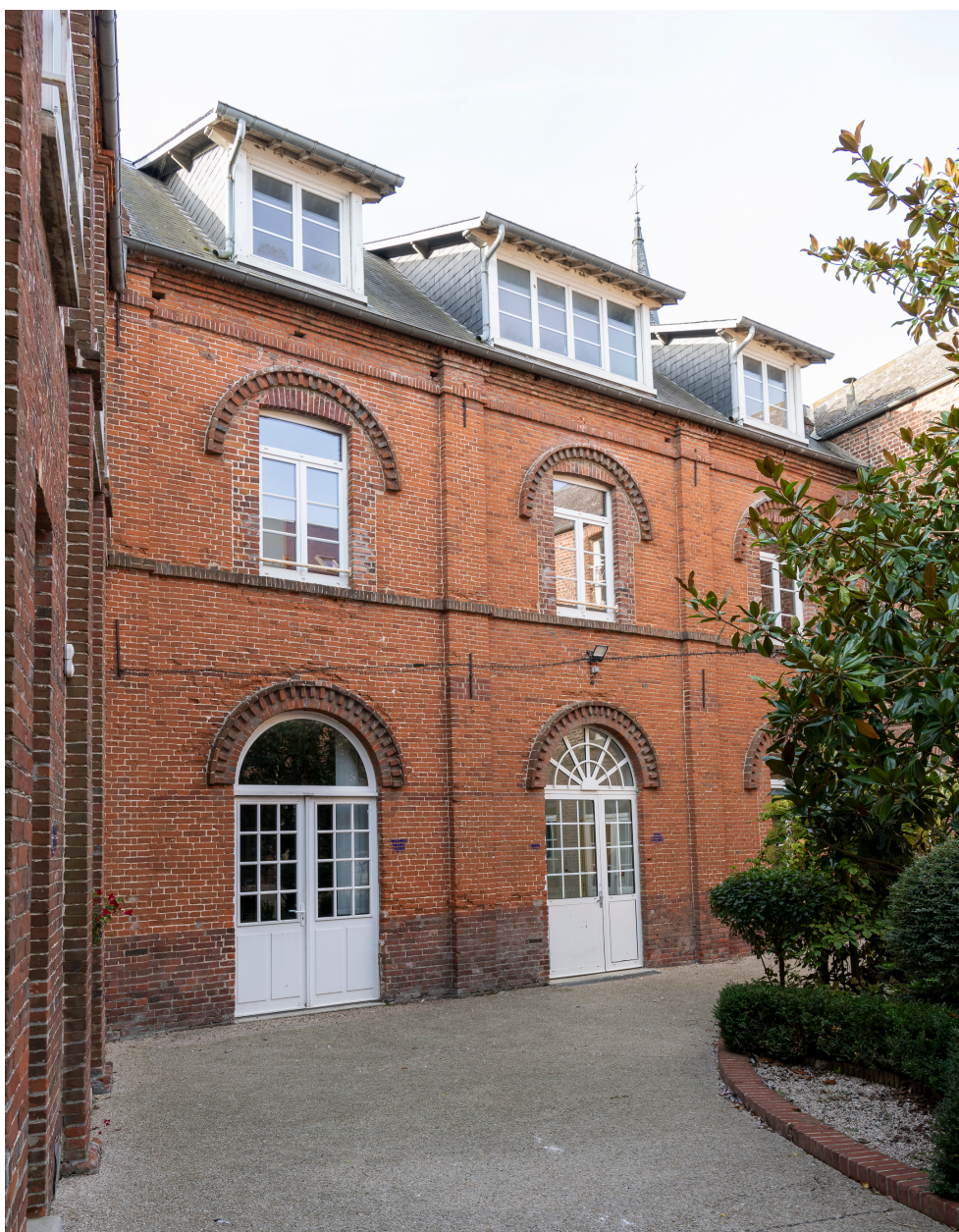
Cour sud : bâtiment sud aligné sur la rue Anne-Marie Javouhey.
