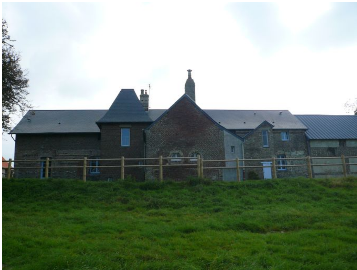
Vue postérieure du logis.
