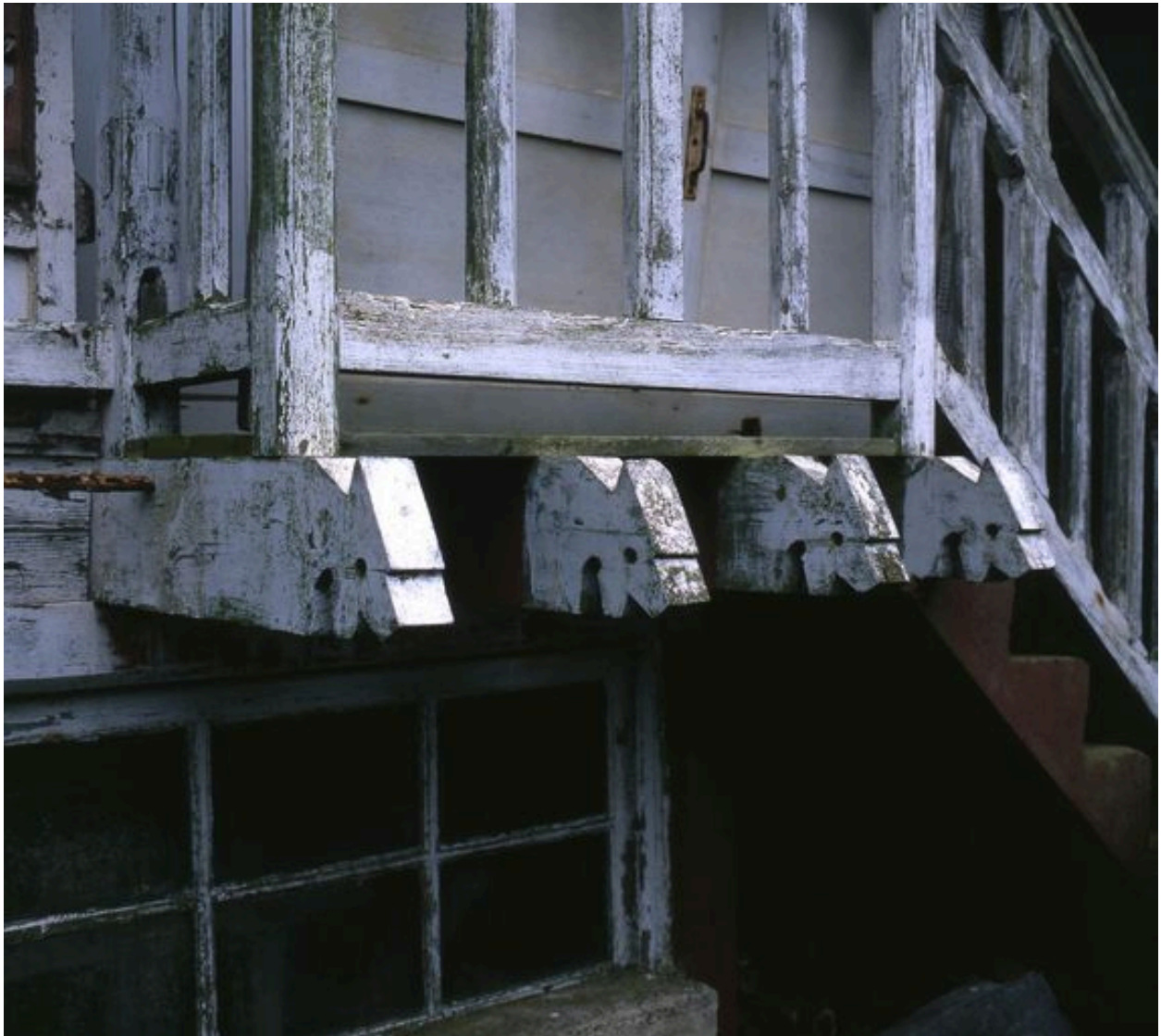
Détail des menuiseries extérieures.
