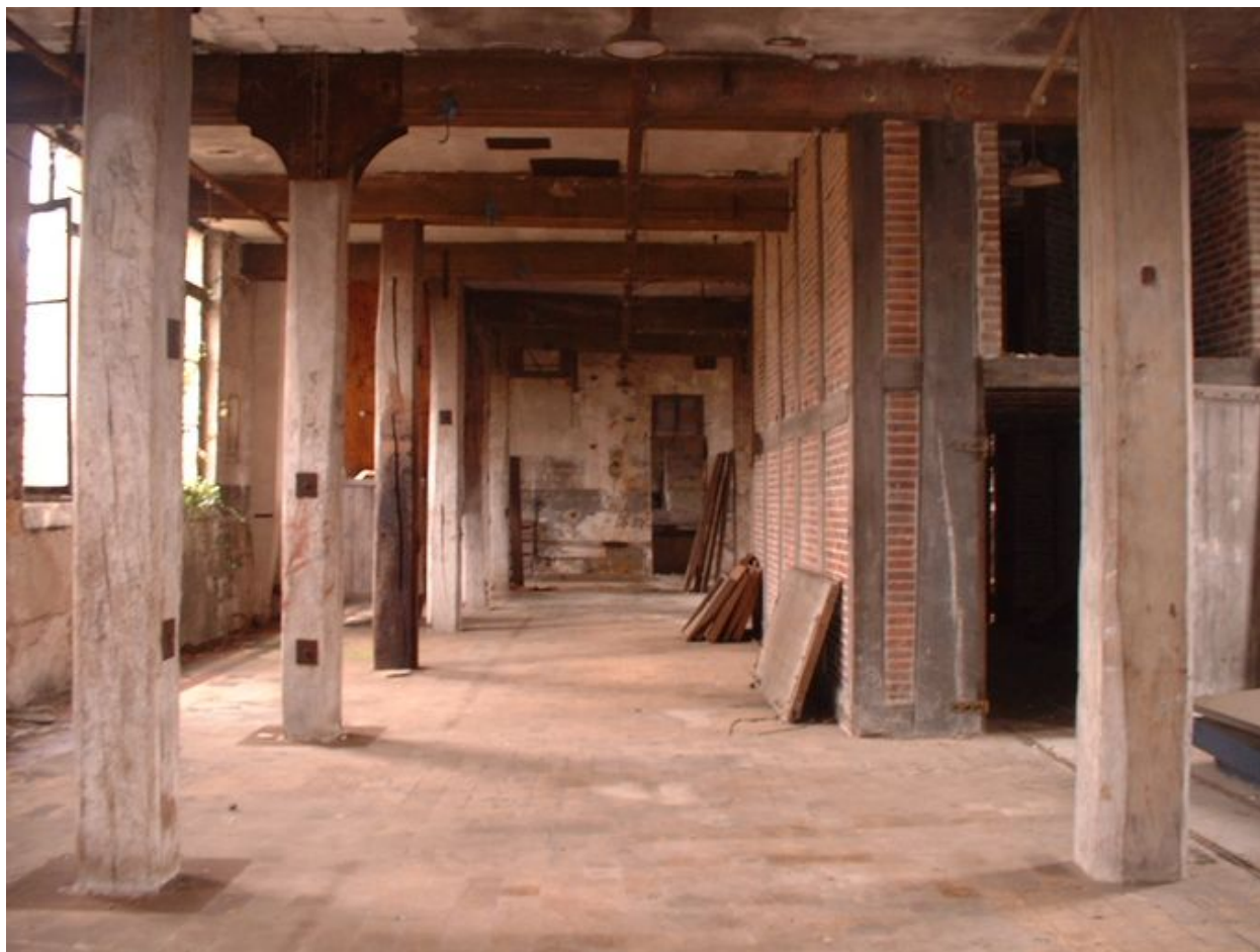
Intérieur de l'atelier de séchage des pates, avec le haloir en brique.
