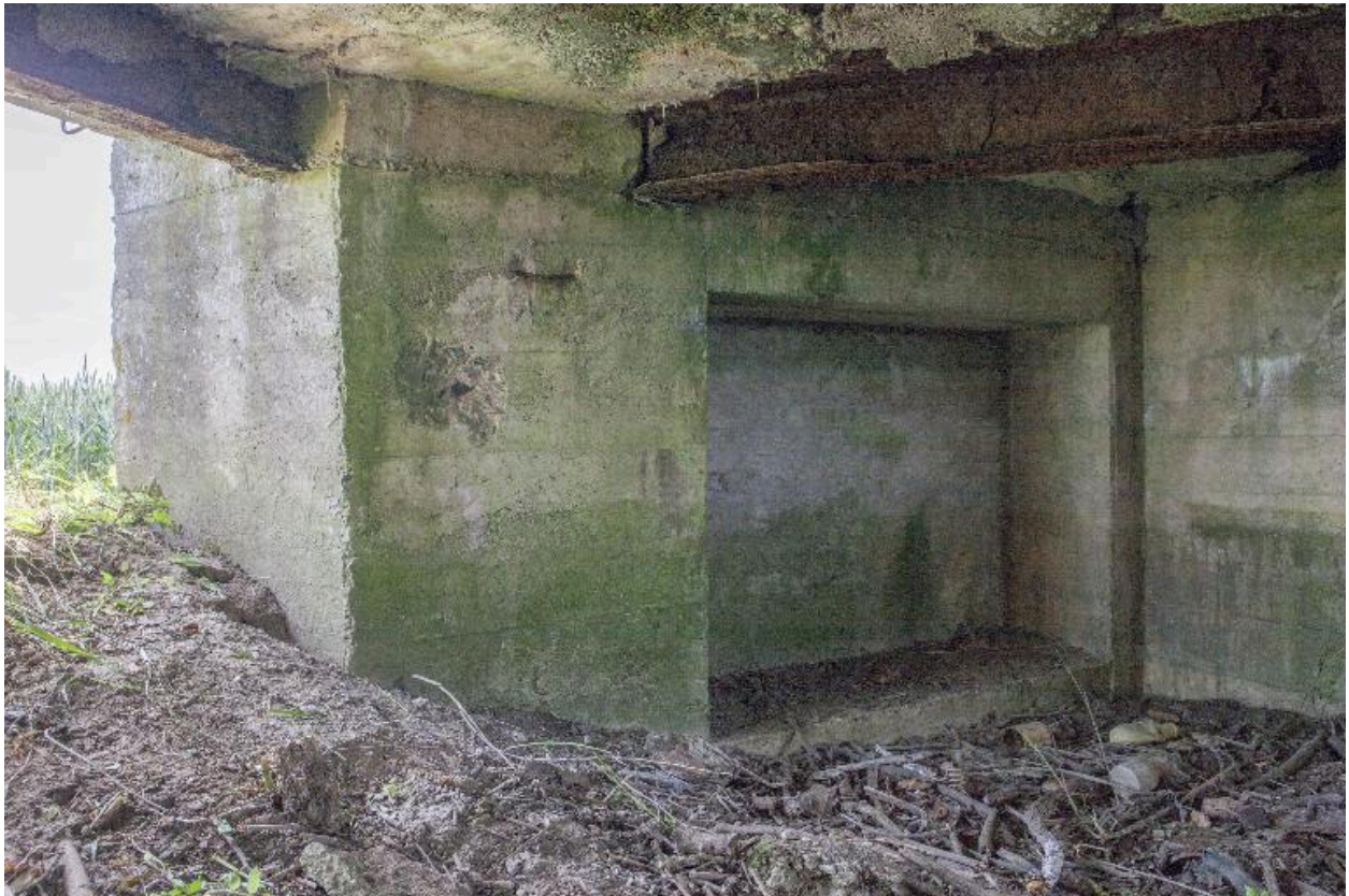
Chambre de tir, niche ouest
