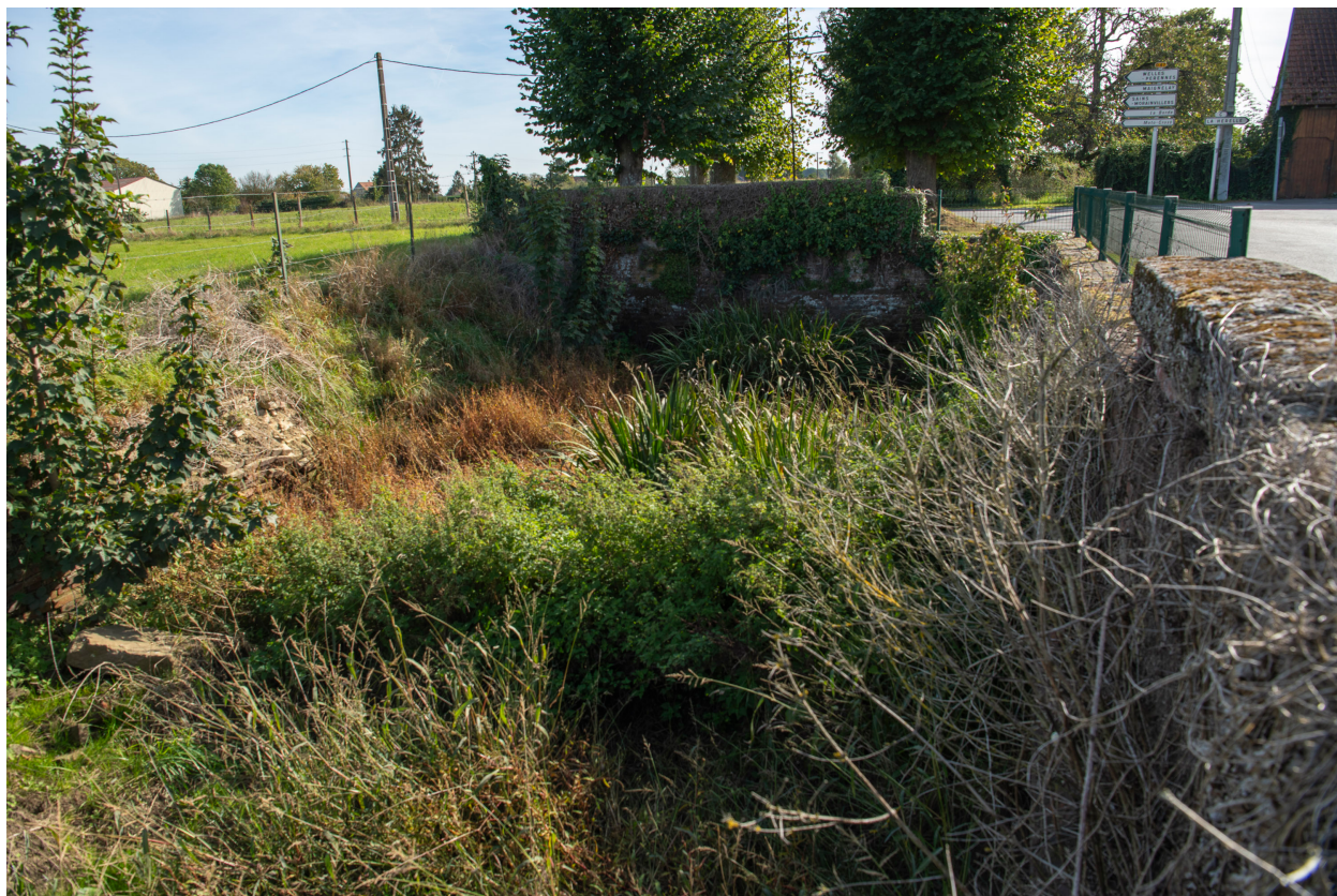
Ancienne mare, rue de la Ploye, vue depuis le nord.
