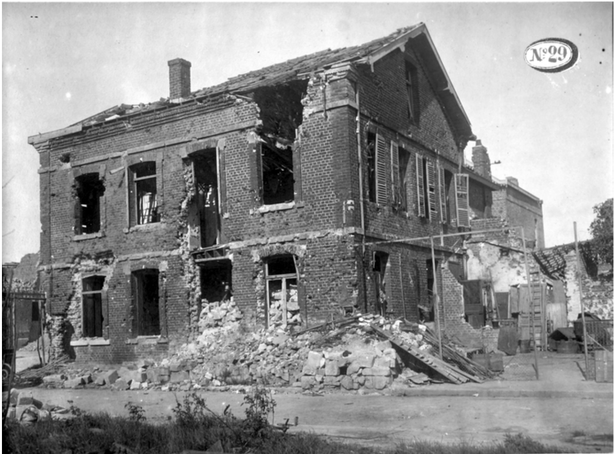
Ancien logement du directeur photographié depuis la cour de l'usine, vers 1919 (AD Aisne).
