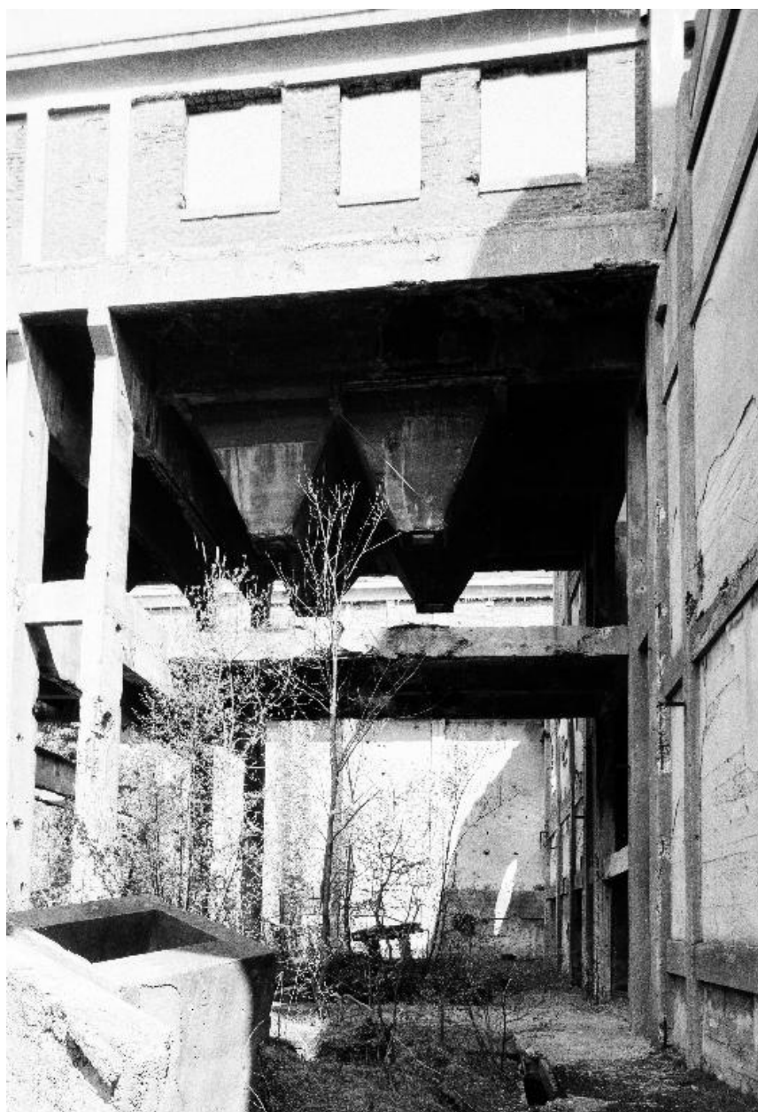
Atelier de fabrication, premier étage, goulottes.
