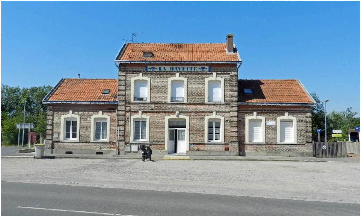
Vue générale de la gare depuis la rue Victor Hugo
