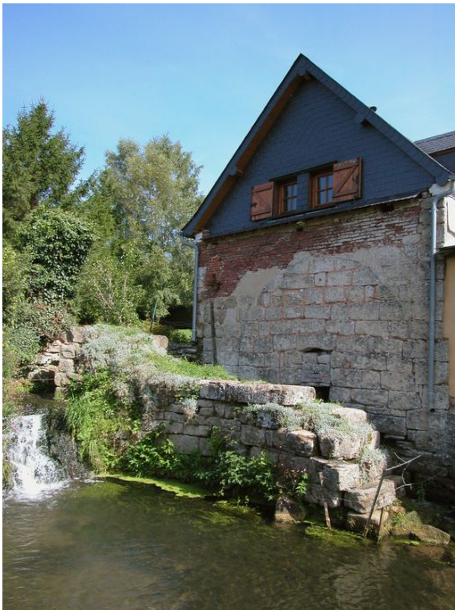
Détail du pignon du moulin hydraulique.
