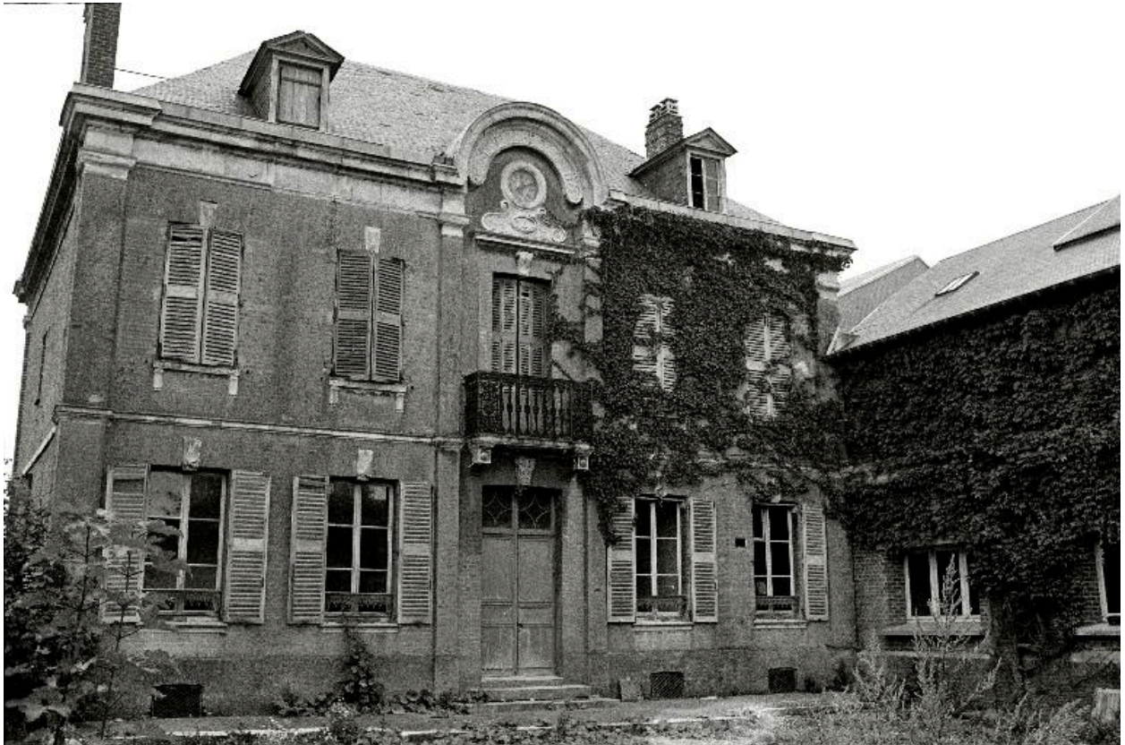
Vue générale, en 1990.
