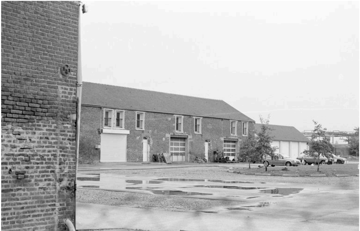
Façade sur cour de l'ancienne bouverie.
