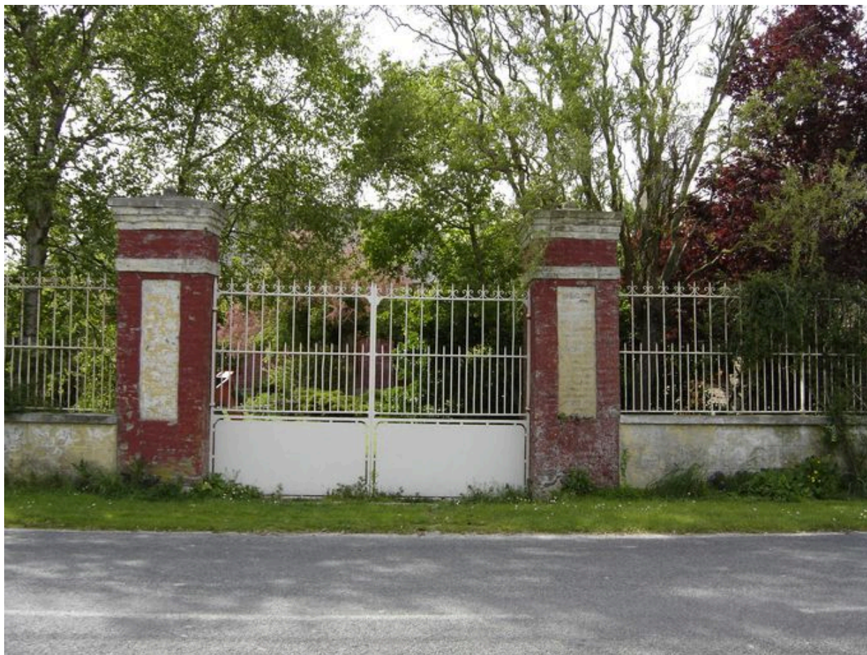
Vue de face de l'entrée.
