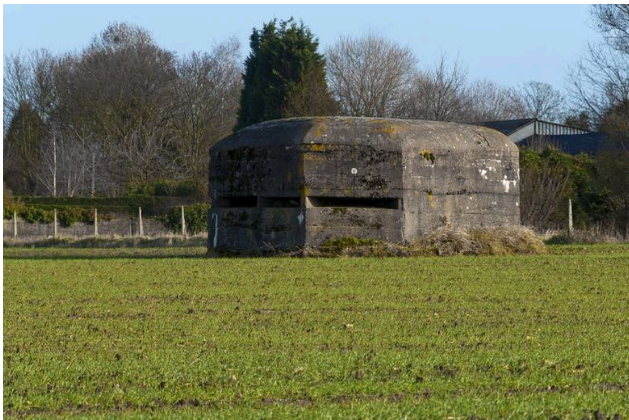
Vue générale, vers l'est
