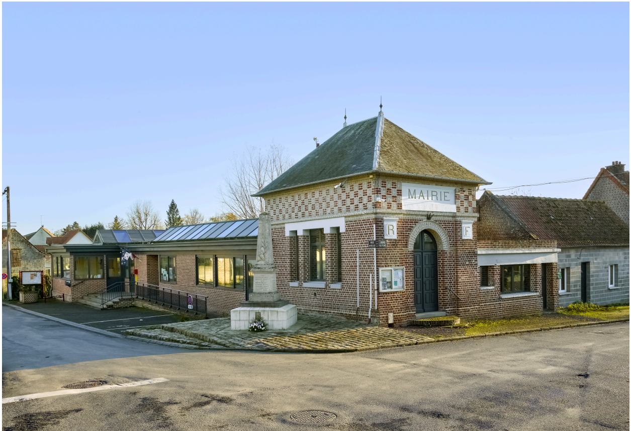
Vue d'ensemble de la mairie, depuis le nord.
