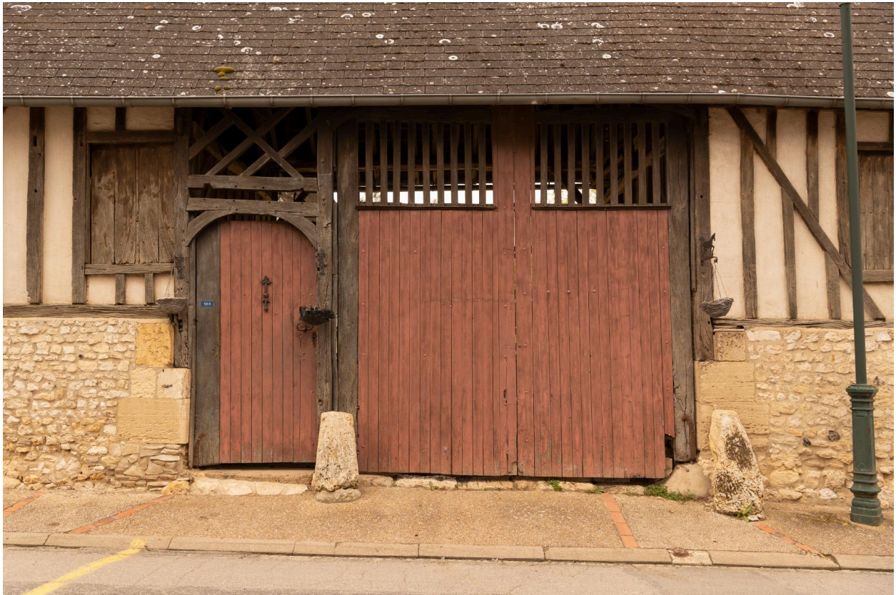
Entrée charretière et porte piétonne, n°184 de la rue de l'Église, vue prise depuis le sud.
