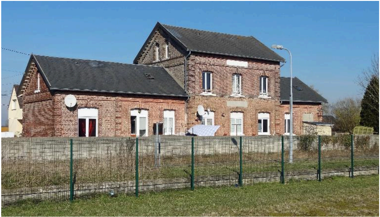
Vue générale de la façade sur voie.
