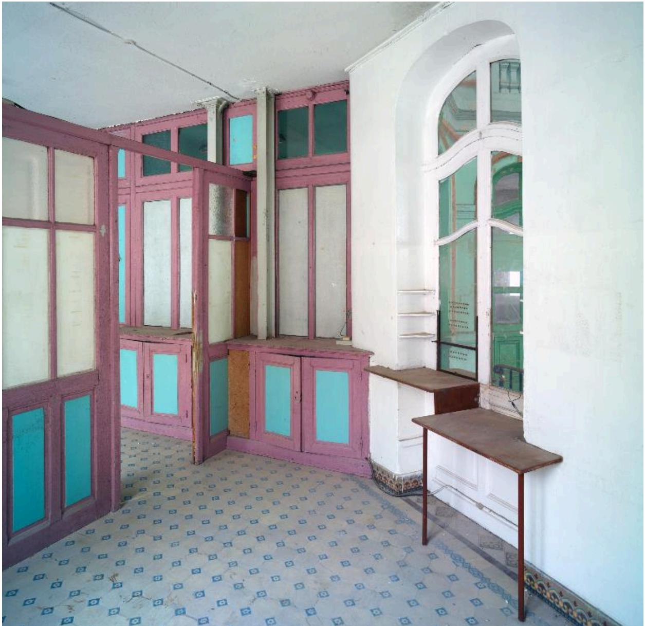
Bâtiment central, rez-de-chaussée. Vue du bureau.
