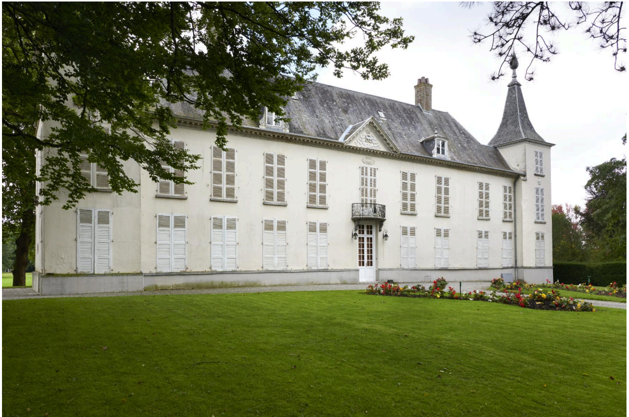
Façade est du château.
