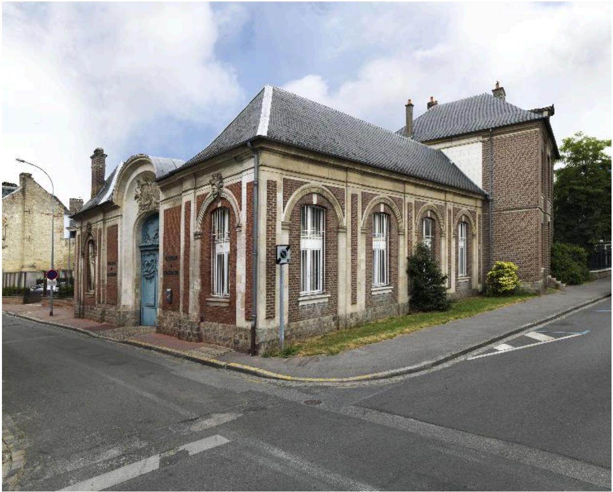
Vue générale depuis le croisement des rues Lesueur et du Chevalier-de-La-Barre.
