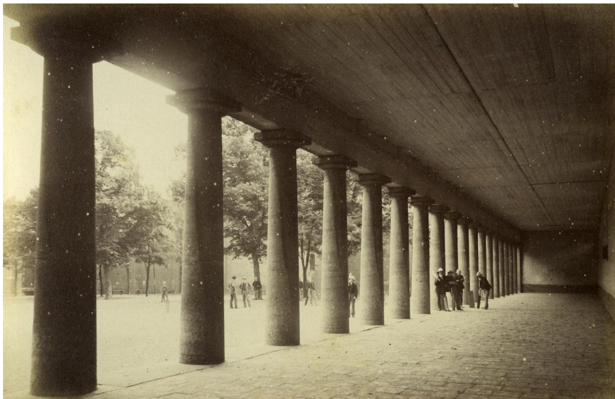
Rez-de-chaussée de la colonnade de l'aile ouest. Photographie, avant 1903.
