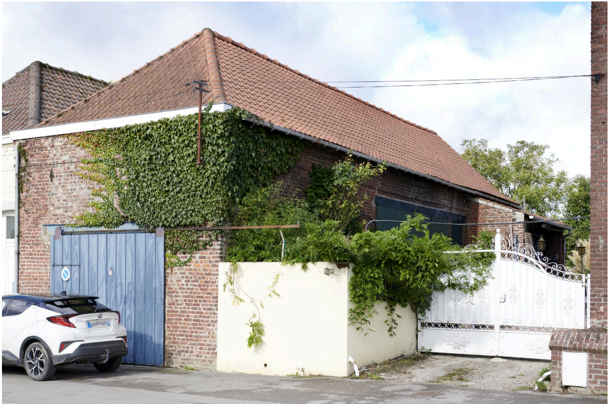
Bâtiment agricole à gauche du logis.
