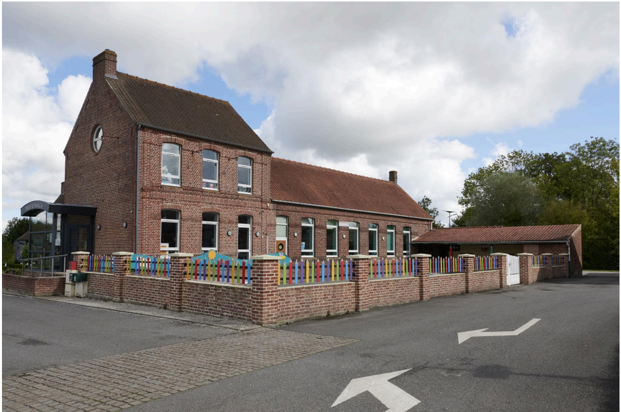
Pignon ouest et façade sud sur cour.
