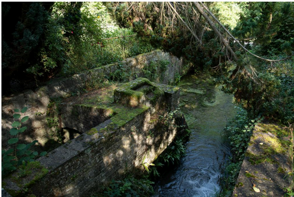
Vue générale des vestiges des mécanismes de l'ancien moulin.
