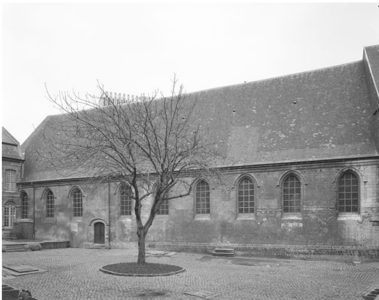
Cour principale, élévation du bâtiment situé au nord de la cour, qui abrite la grande salle des malades et la chapelle, vue générale.
