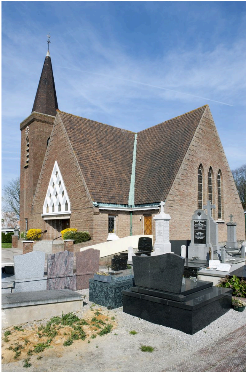
Élévation antérieure et flanc droit.
