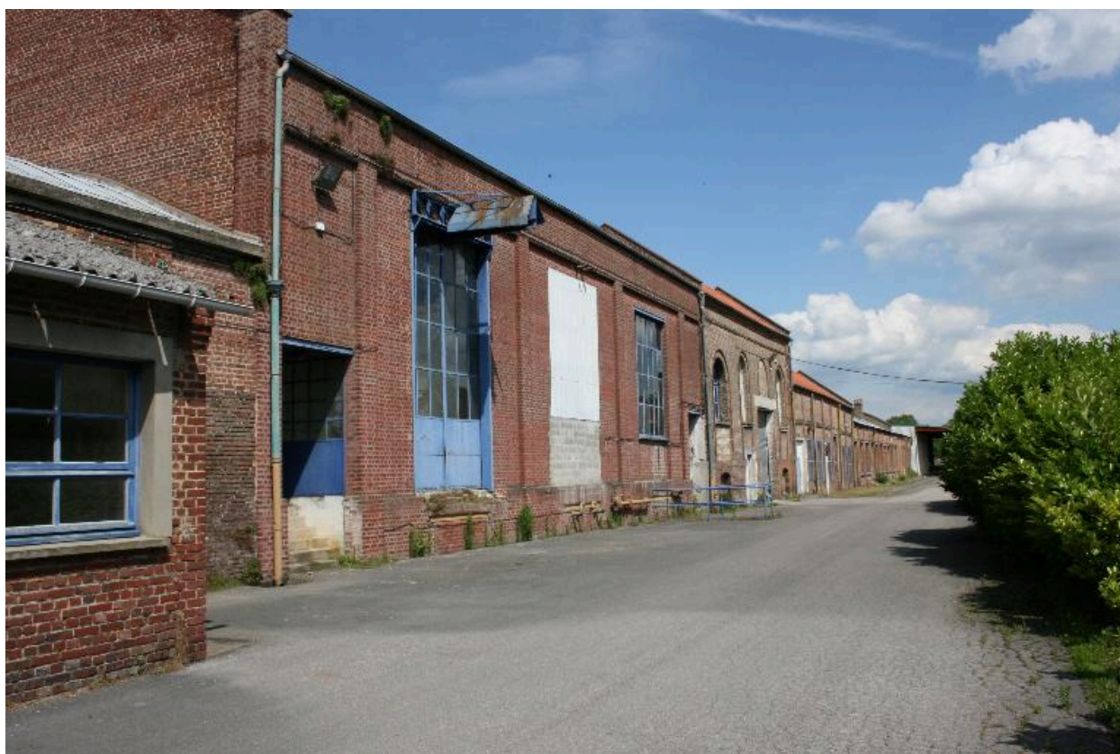
Façade sud des magasins.
