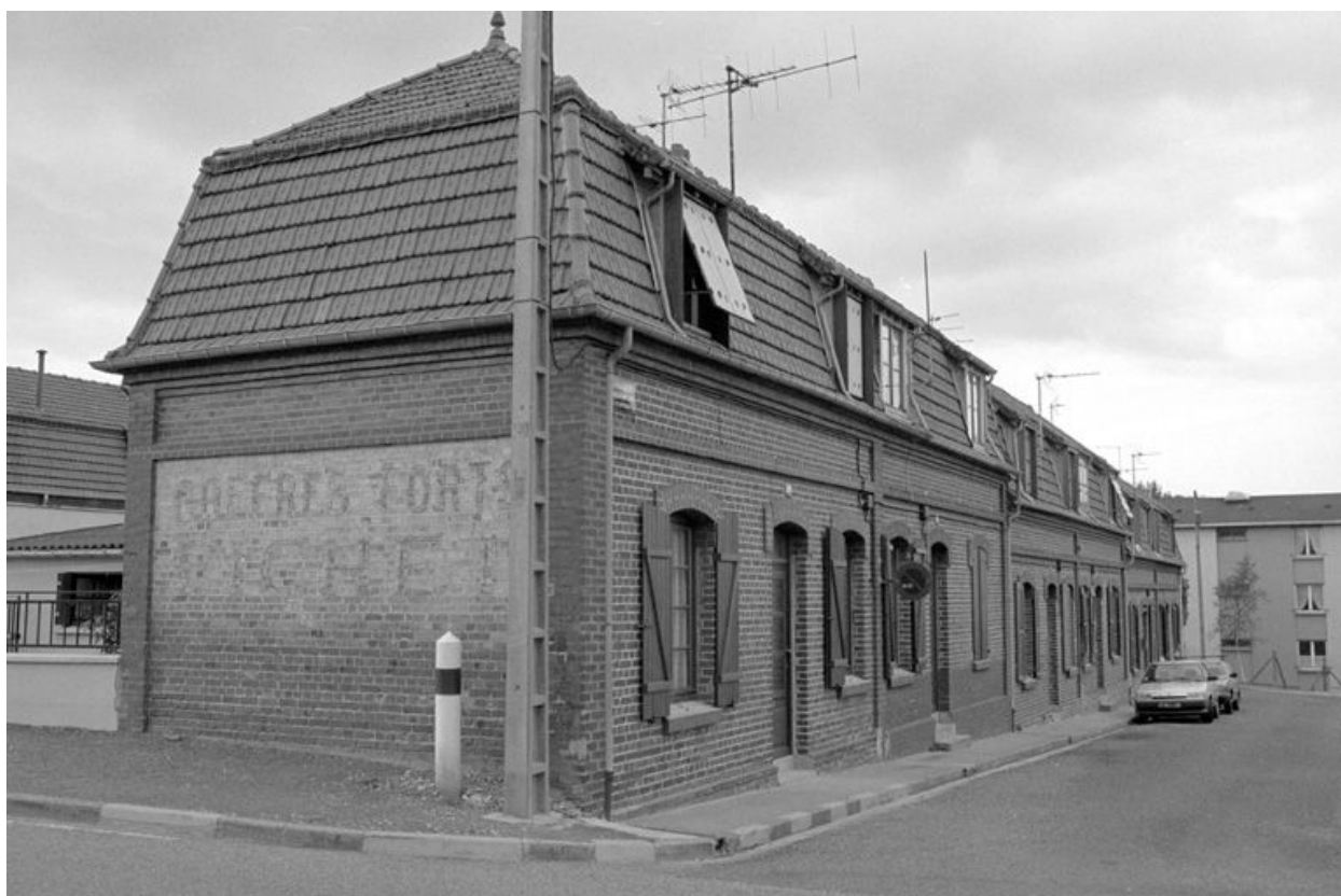
Logement d'ouvriers rue Joseph-Depailly, élévation antérieure.
