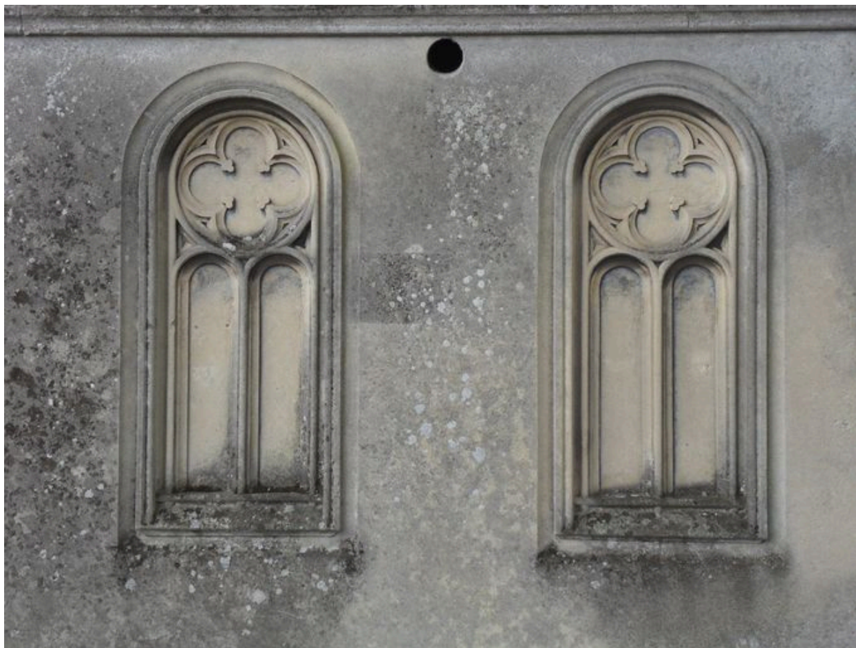
Vue de détail des baies aveugles du mur sud.
