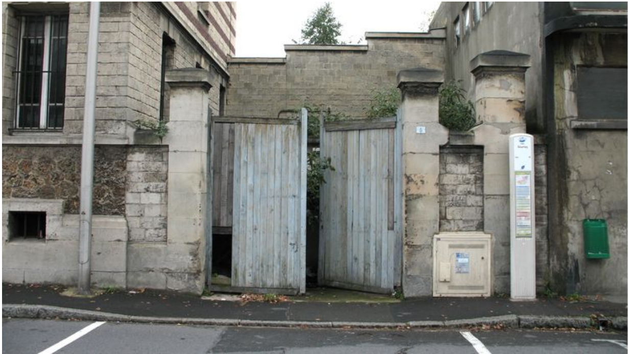
Portail d'entrée des bureaux.
