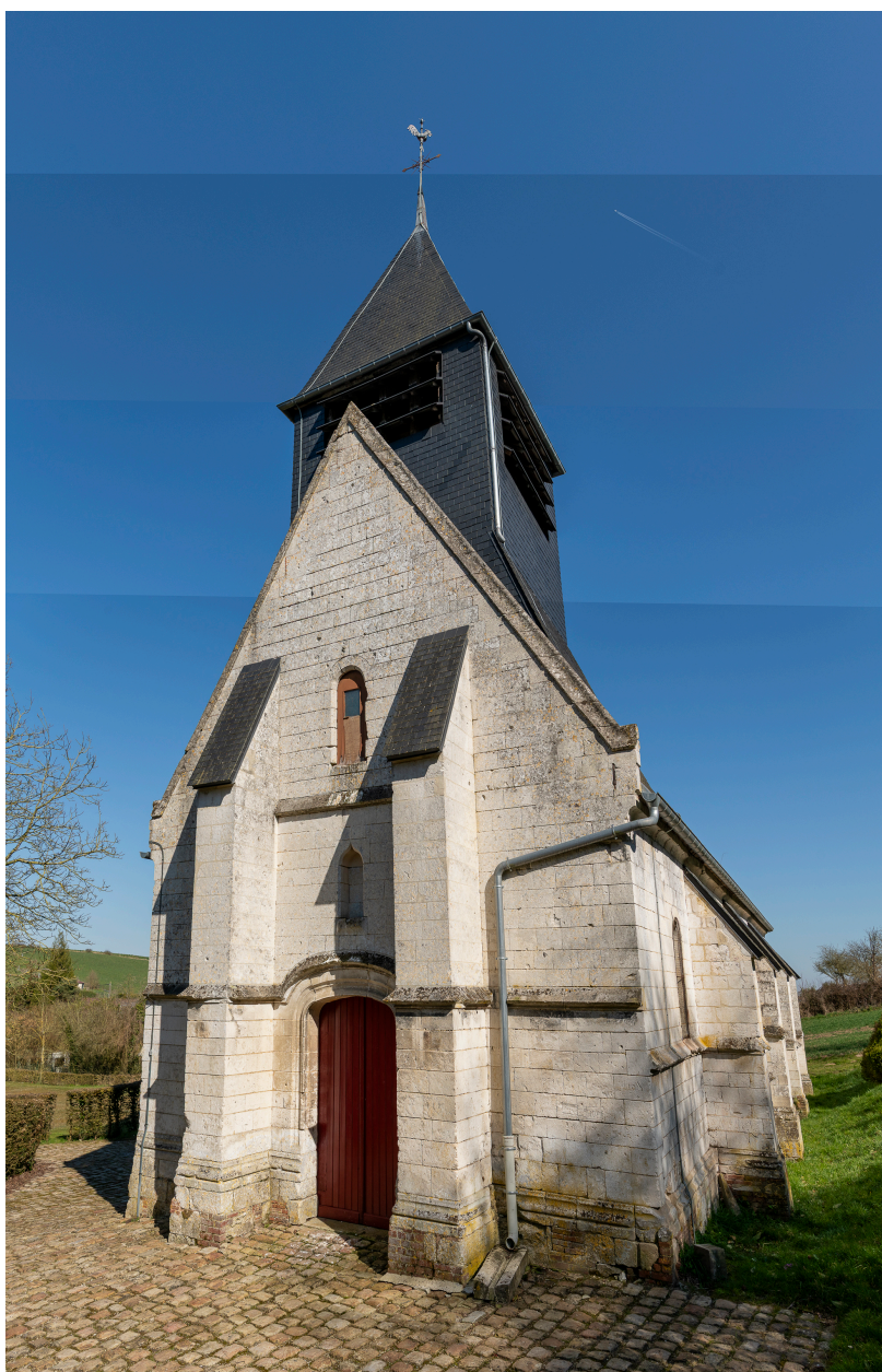
Vue de la façade occidentale.
