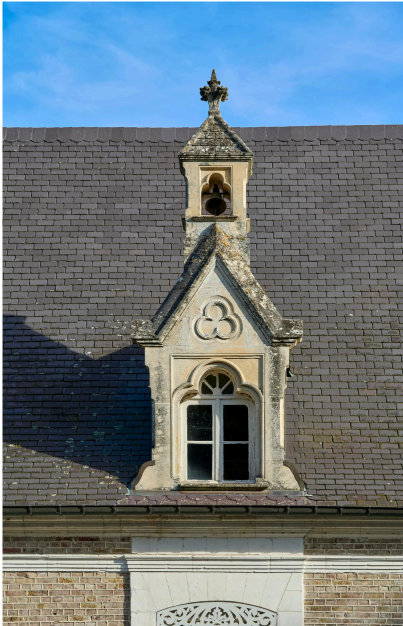
Détail de la lucarne, travée centrale de l'élévation sud.
