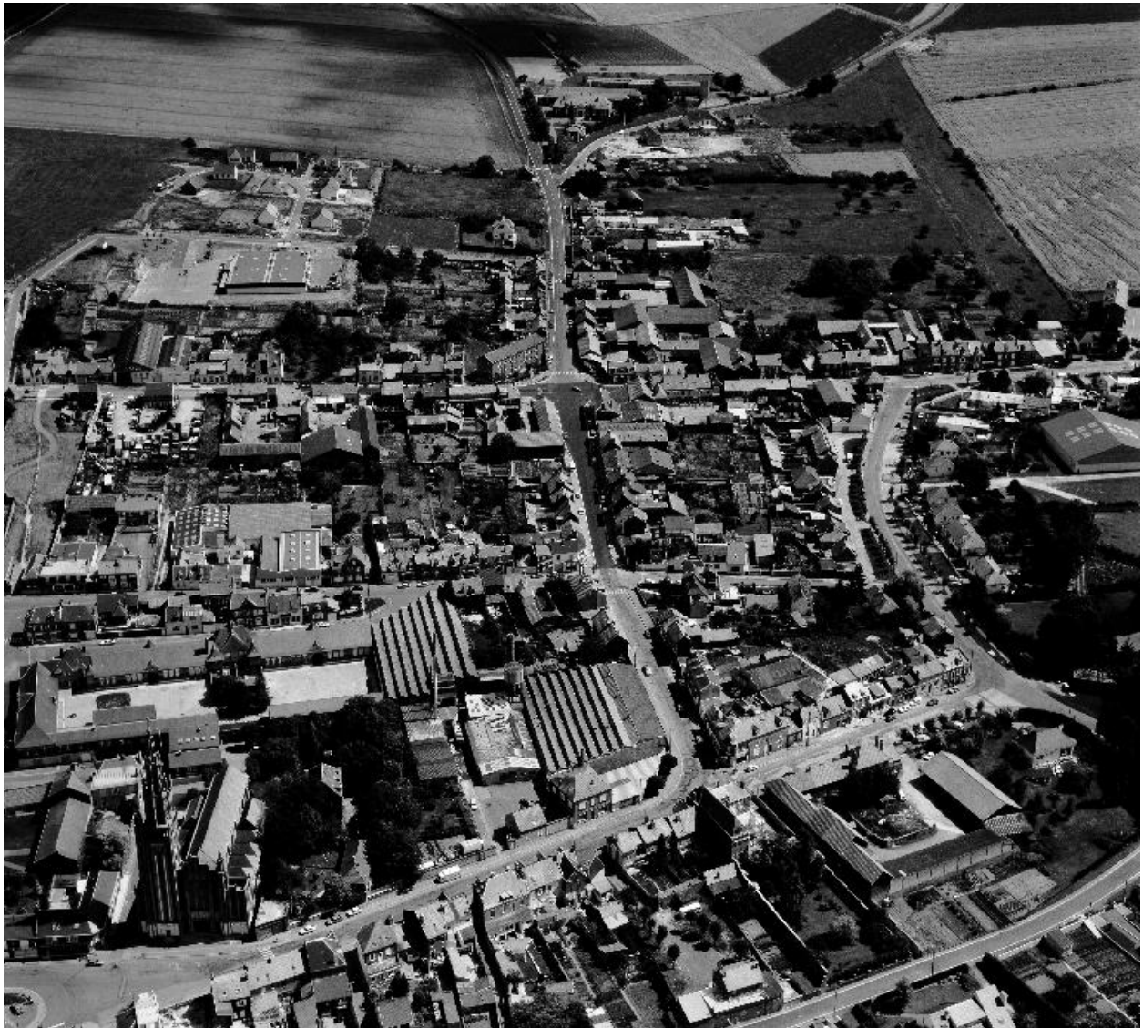
Vue aérienne, flanc ouest.
